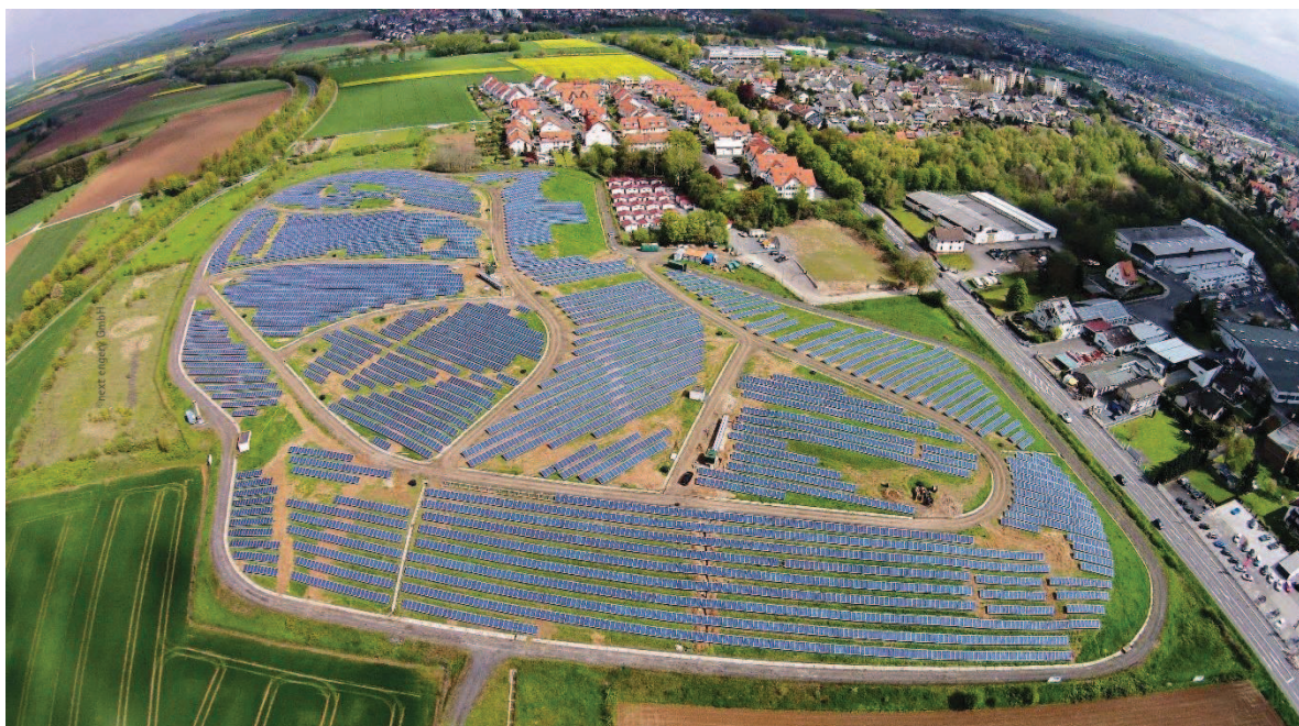
Abbildung 6: PV-Anlage der Kreiswerke-Tochter Versorgungsservice Main-Kinzig GmbH auf der ehemaligen Deponie Bruchköbel / Bildquelle: Versorgungsservice Main-Kinzig GmbH
