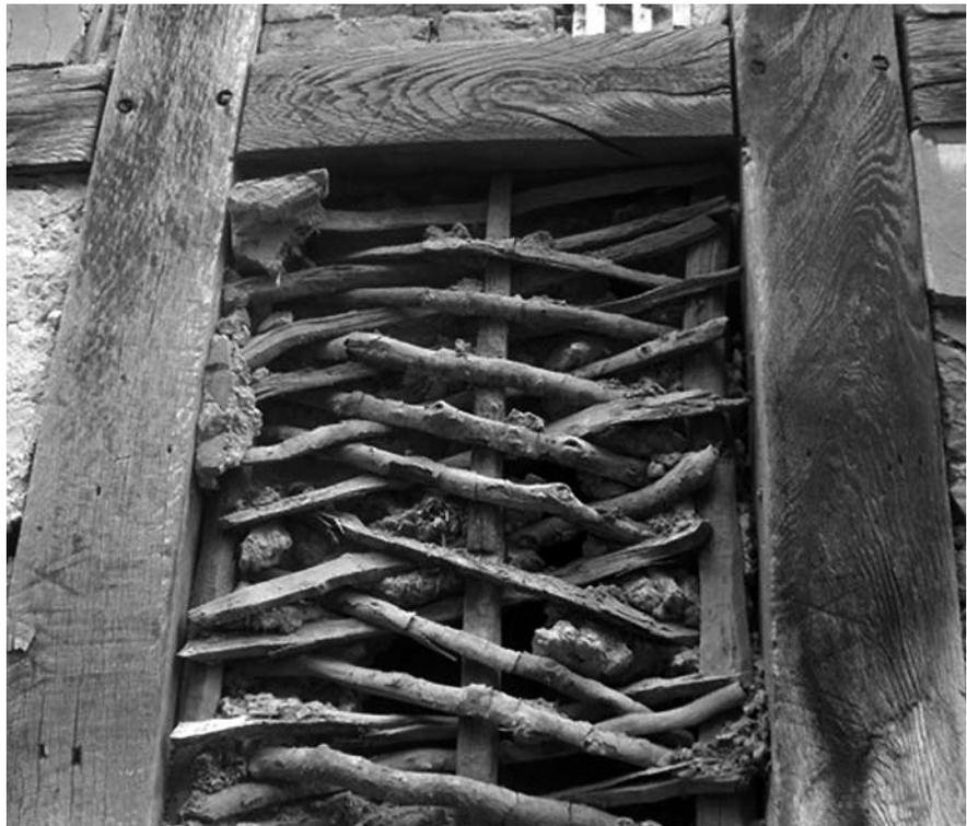
**Abb. 2** Neuzeitliche Ausfachung einer Fachwerkwand in Rauschholzhausen.
