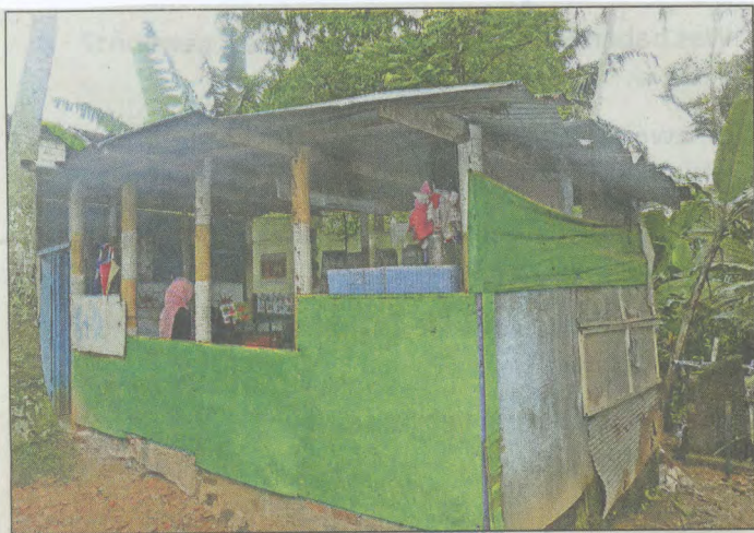
Aus alt mach neu: Ein Kindergarten, der mehr einer notdürftig zusammengesetzten Blechhütte gleicht, wird in Maradana durch einen Massivbau ersetzt.
